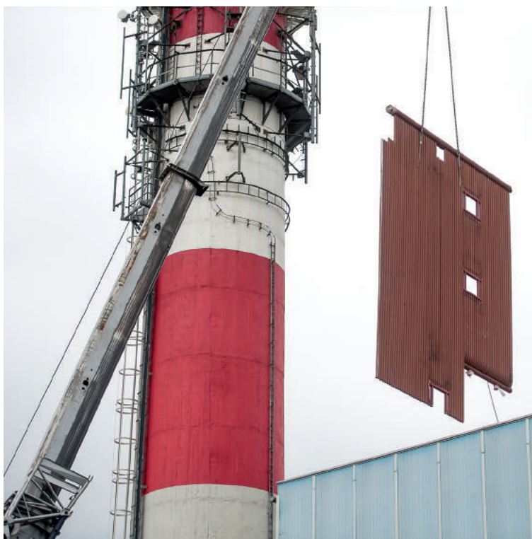
fot. arch. ciepłowni, Modernizacja źródła ciepła
