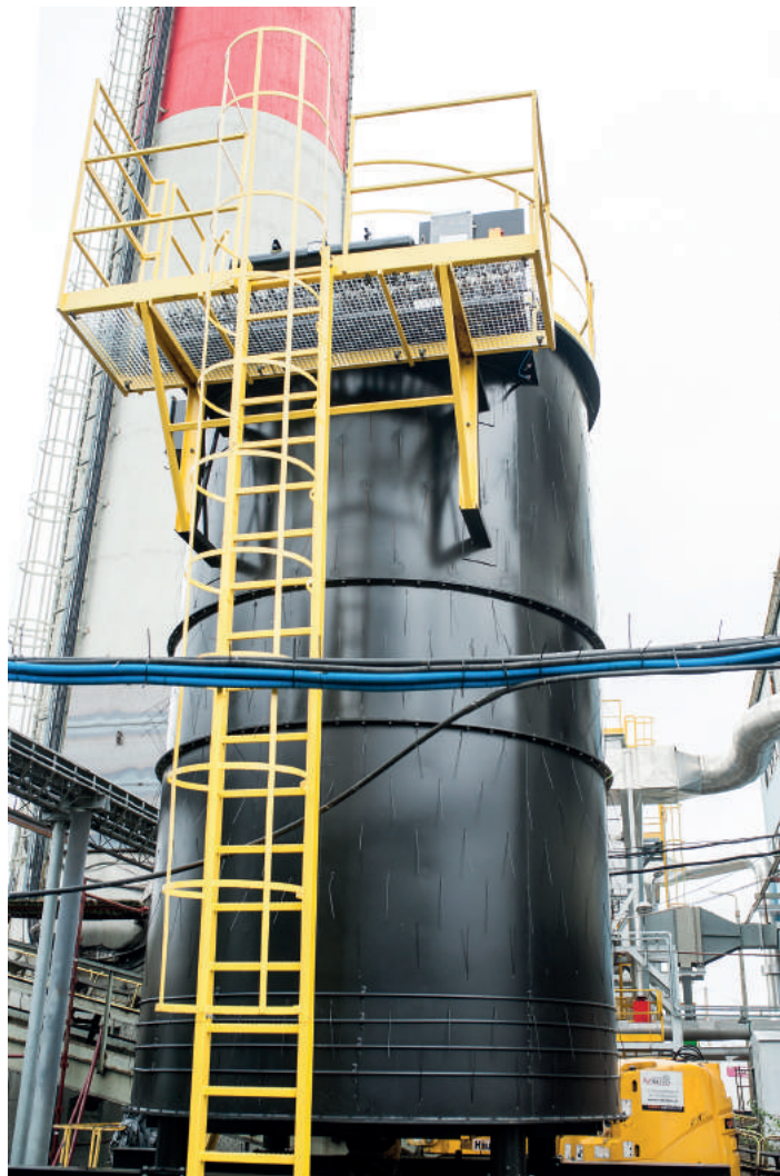
fot. arch. ciepłowni, Modernizacja źródła ciepła
