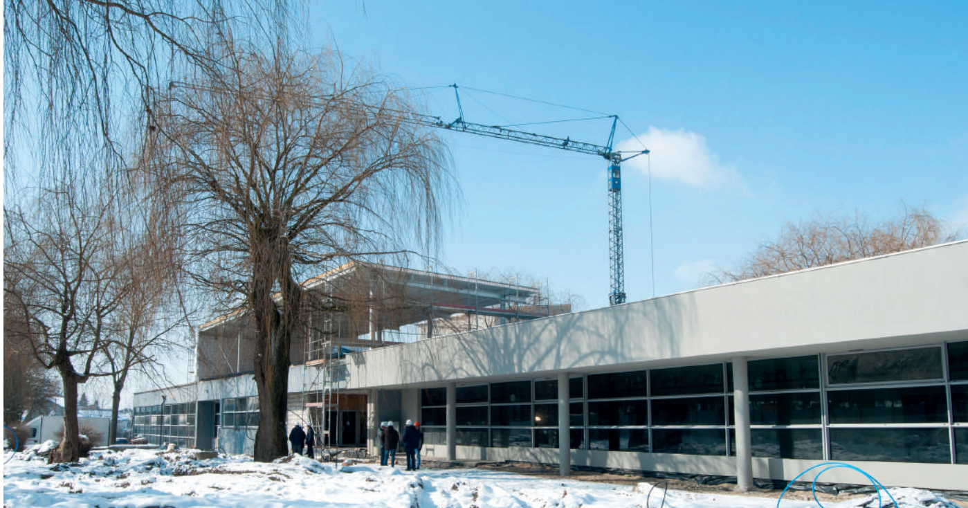
fot. lancut.pl, Rozbudowa i przebudowa MDK
