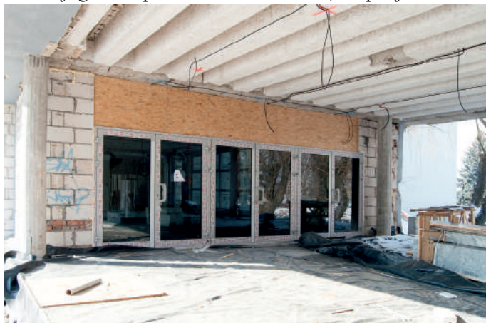
fot. lancut.pl, Rozbudowa i przebudowa MDK
