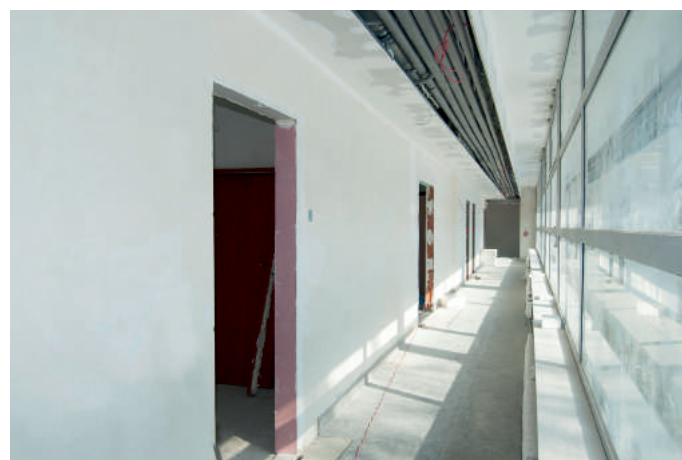
fot. lancut.pl, Rozbudowa i przebudowa MDK
